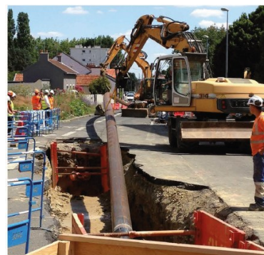
Travaux de réseau de chaleur bd Jules Verne photo ©Erena
