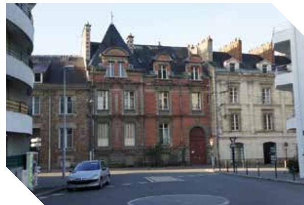
Opération Habitat et Humanisme rue de la Bastille à Nantes
