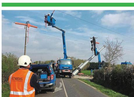
Les techniciens d'Enedis réalisent une opération rare et très délicate : le levage d'un poteau métallique sous une ligne électrique sous tension (20.000 volts).
